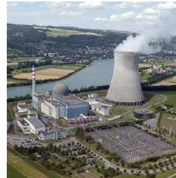
Betriebsgelände der Kernkraftwerke
